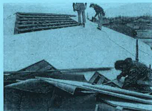
痛んだ下地を補修し 野地池の施工
